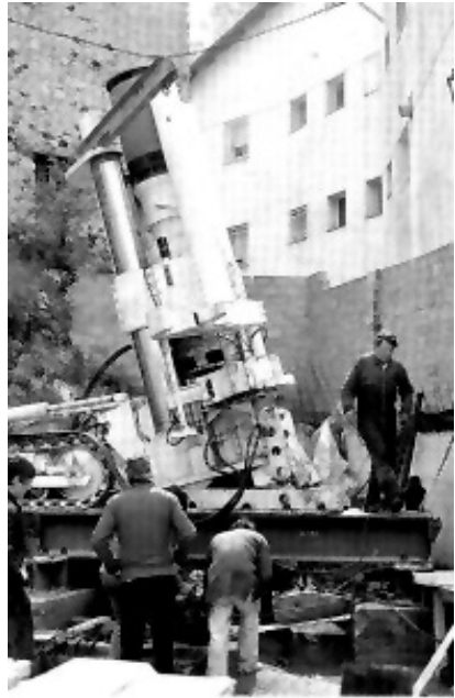
Figura 2: perforació del pou termal d'Escaldes. Font: Enginesa
