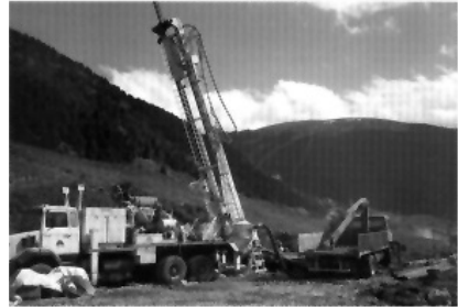
Figura 3: perforació del pou termal d'Incles. Font: Enginesa
